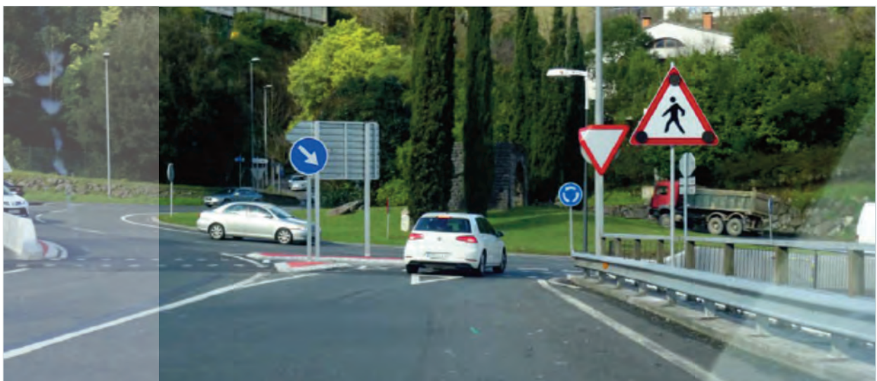
Fotografía 10.- Zona de cruce en la que la señal P-20 está demasiado cerca del cruce y éste no se percibe adecuadamente.
